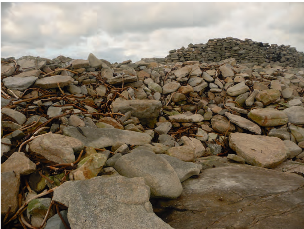
Fig. 3. Vue des dalles projetées en haut de platier. Notez l'absence de lichen sur les dalles du bas et le niveau atteint par les tiges de laminaires, témoignant du brassage du secteur par la mer (cl. : L. Dutouquet).
