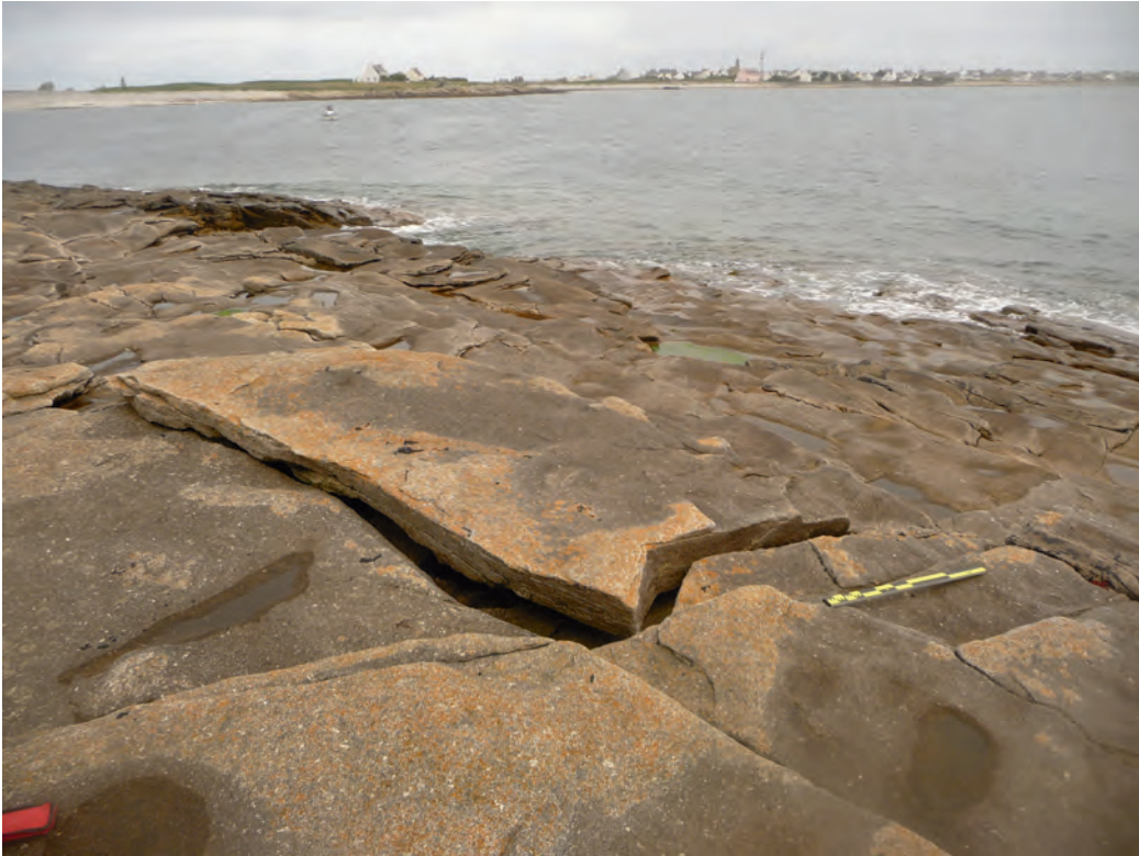
Fig. 2. Arrachage et déplacement d'une dalle suivant les plans de diaclase naturels du platier rocheux granitique (cl. : L. Dutouquet).
