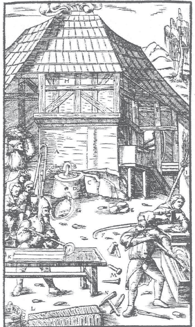
A : Le fourneau B : Sa bouche C : Bassin de coulée ou avine tóver D : Son ouverture E : Les déchets F : Houe G : Le second bassin H : Les parois de la cheminée I : Balai K : Les plaques de cuivre pour étendre l'étain L : Treillis d'étain M : Poinçons de fer N : Marteau
