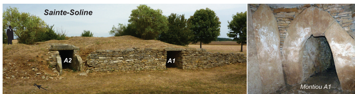
Fig. 31 : Montiou A1 (Sainte-Soline, Deux-Sèvres). Le cairn A et les entrées au sud-est des deux tombes à couloir A1 et A2 ; la porte monolithique au passage couloir-chambre A1 (clichés D. Michelet et S. Cassen).
