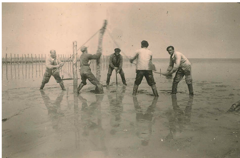
Fig. 352 : Enfoncement manuel de pieux dans la baie du Mont-Saint-Michel vers 1950 (photo : A. BUSSON ; fonds écomusée de la Baie-Vains).
