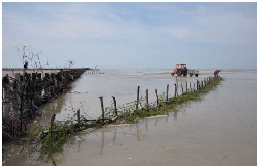
Fig. 354 : Construction d'un hairon destinée à protéger la pêcherie Maillard à Hauteville-sur-Mer en contrôlant l'écoulement d'un chenal (photo : L. CHATELAIS, 2014).
