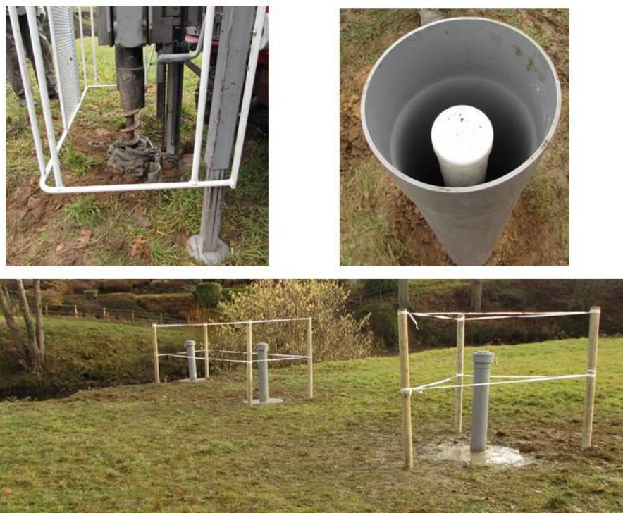
Figure 12. Mise en place de trois piézomètres sur le site du programme Sélune (photo : M. Fauchoux).
