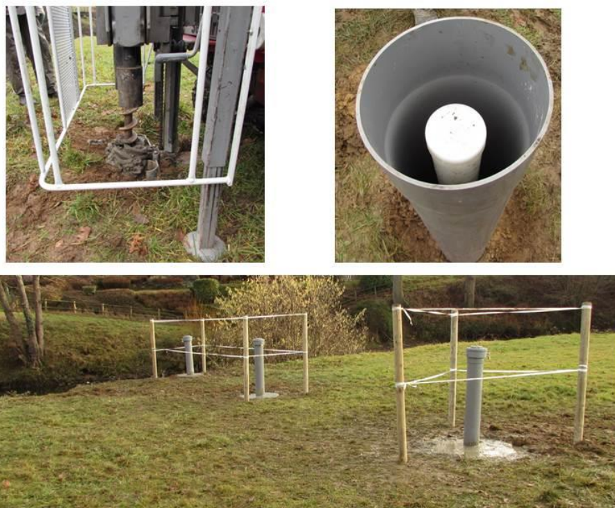
Figure 12. Mise en place de trois piézomètres sur le site du programme Sélune (photo : M. Fauchoux).
