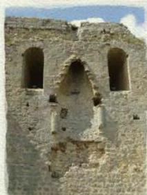
Le mur ici dégagé devait être assez important, soutenu par un contrefort. Il était percé d'une porte, dont l'emplacement est signalé par un seuil et une feuillure. Le niveau du seuil indique le niveau de circulation et témoigne de l'état d'arasement des bâtiments.
