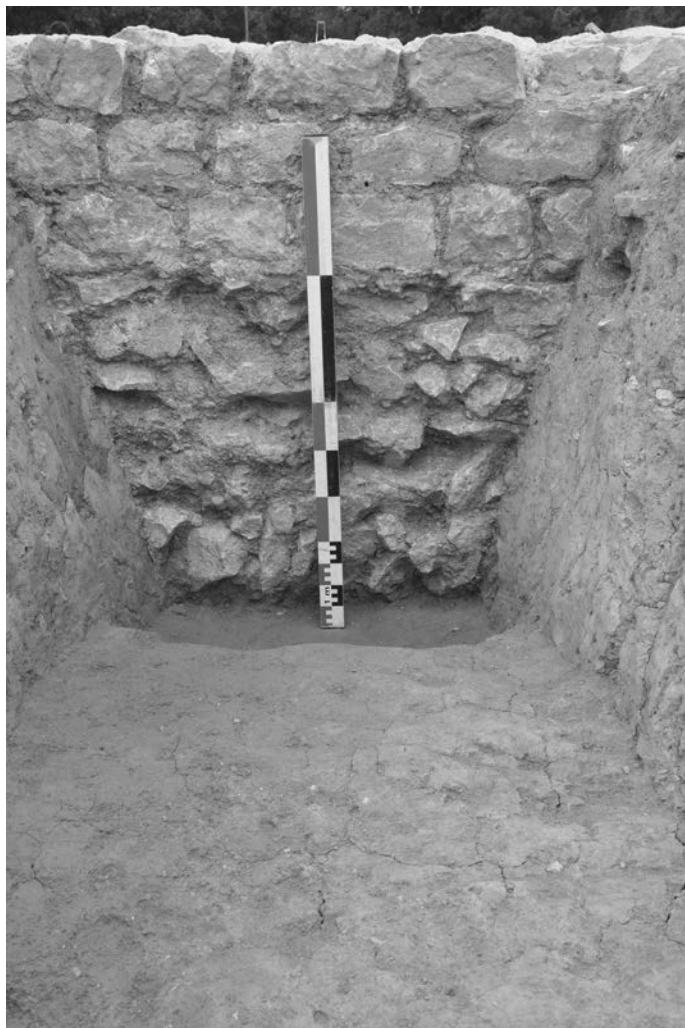
Fig. 6 – Fondation et élévation conservée du mur MR31 (cliché : F. Colleoni, Université de Rennes-II).
